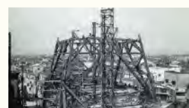
建設中の2代目通天閣
